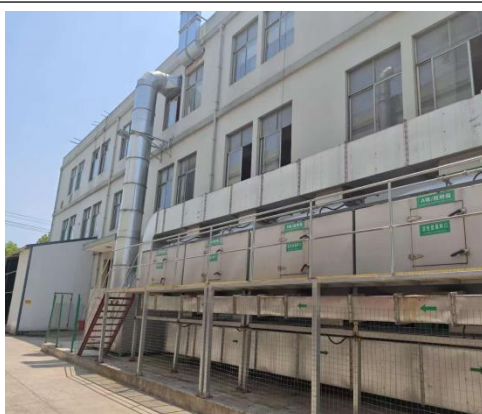
“双极气旋混动喷淋塔+干式过滤箱+活性炭吸附脱附催化燃烧”装置
