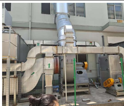
“双极气旋混动喷淋塔+干式过滤箱+活性炭吸附脱附催化燃烧”装置
